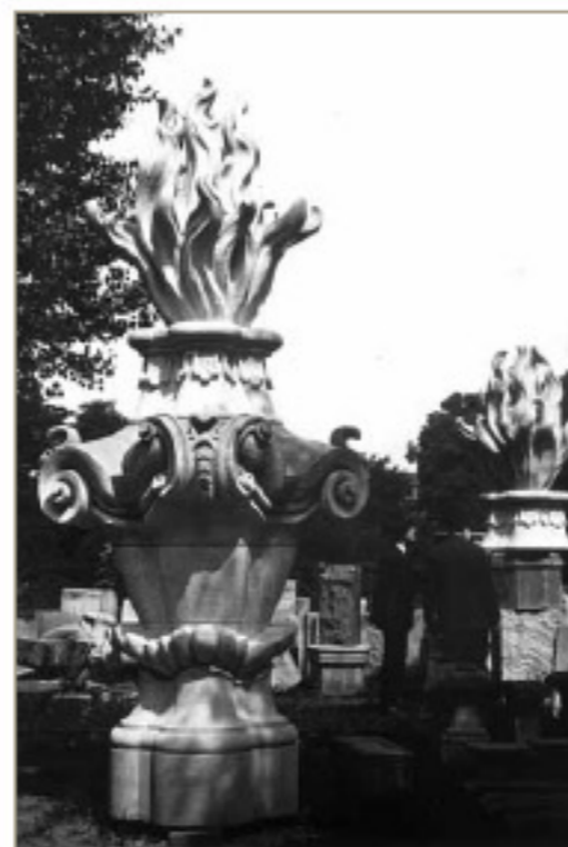
Die in den 1920er-Jahren aus schlesischem Sandstein neu gefertigten Flammvasen auf dem Werkplatz
