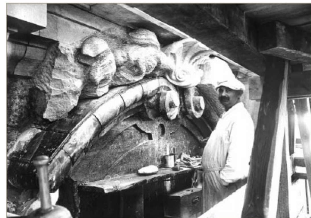
Handwerker bei der Instandsetzung des Zifferblatts in den 1920er-Jahren (SW-Fotos © Brandenburgisches Landesamt für Denkmalpflege und Archäologisches Museum (BLDAM), Messbildarchiv)
