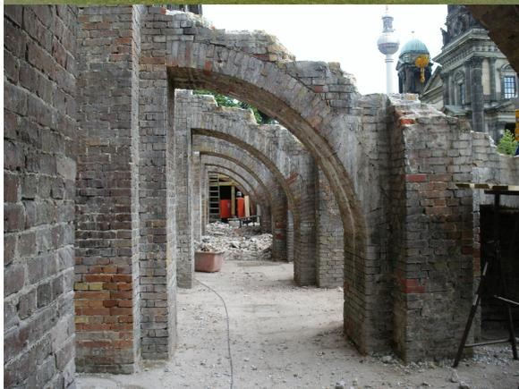
Links: Mauerwerkskonstruktion unter der Treppe
