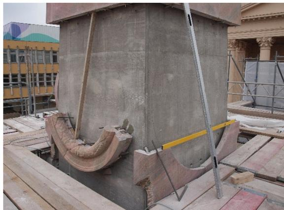
Wiederaufbau Stahlbetonkonstruktion mit Werksteinbekleidung
