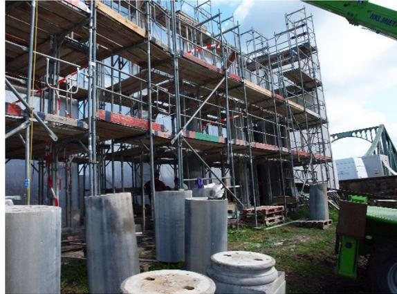
Wiederaufbau der Säulen: Bohrkanäle für vertikale Ankerstangen
